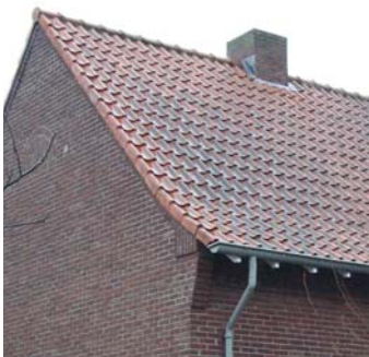
Overstekken en schoorstenen
